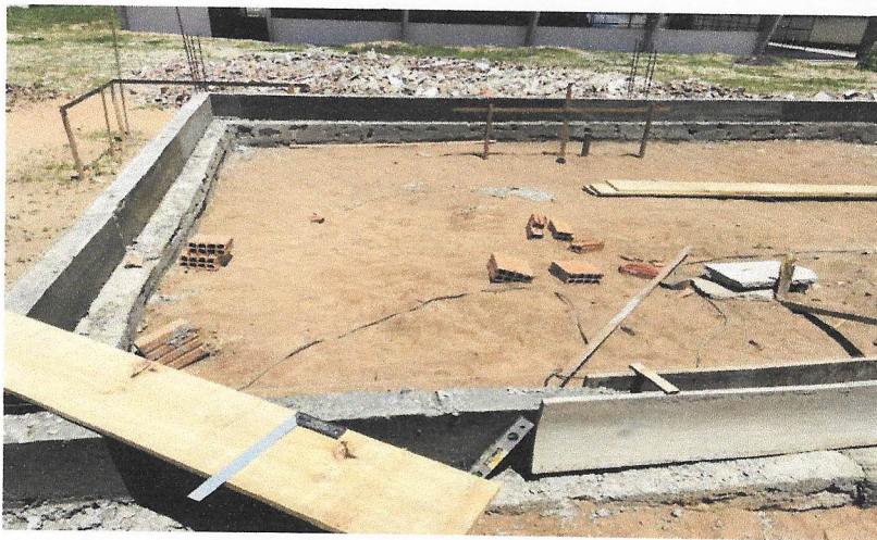
IMPERMEABILIZAÇÃO DAS VIGAS BALDRAMES
