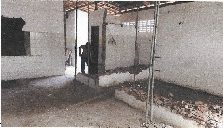
RETIRADA DO TELHADO
