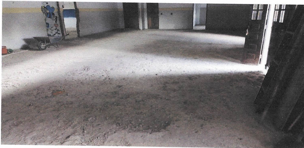
DEMOLIÇÃO DE PISO CERAMICO
