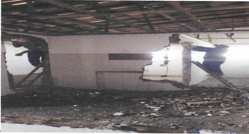
DEMOLIÇÃO DE PAREDES
